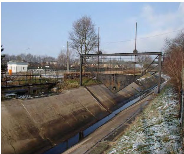
Abb. 3.1-16: Überlaufschwelle Pulheimer Bach zum Kölner Randkanal; 09.02.2013
