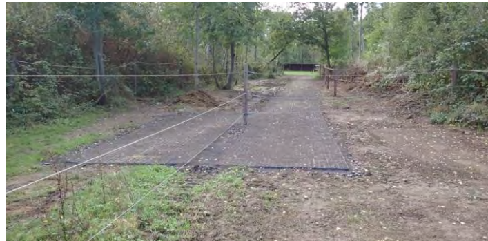
Abb.4.3.2-5: befestigter Weg in ehemaliger Uferrinne; Blick nach Süd auf Pferdebox: 27.09.2024
