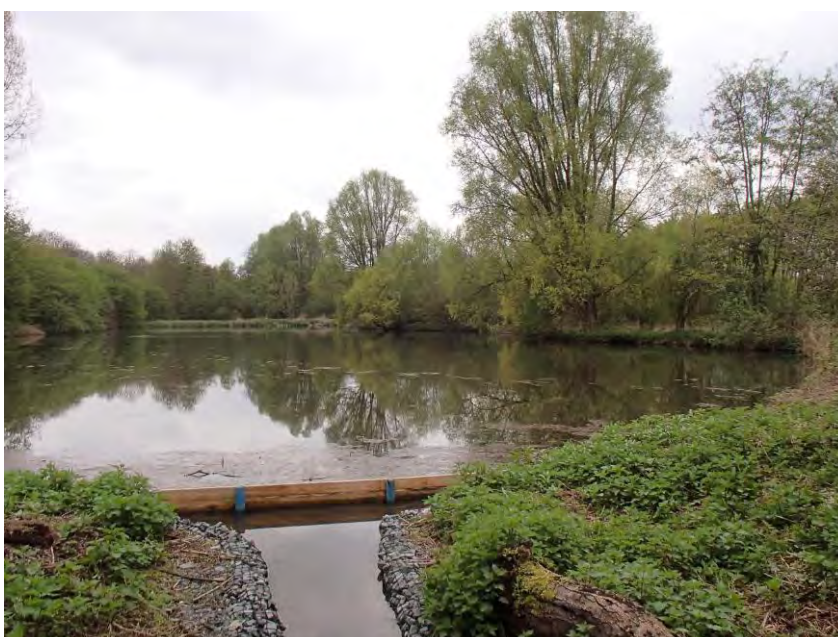
Abb. 4.4.2-19: Teich 3 und Überlaufschwelle mit Tauchwand 27. März 2013
