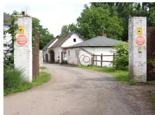
Abb. 5.1-5: Eingang zum Betriebsgelände Pletschmühle mit Verbotsschild; 27. Mai 2024
