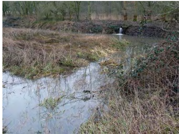
Abb. 4.4.2-11: Reservebecken Nordost 24. Januar 2009
