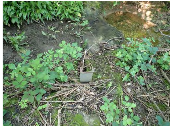
Abb. 4.4.1-3: Betonschwelle Ende Zuleitungsgraben zum Langen Weiher ; 10. Mai 2024
