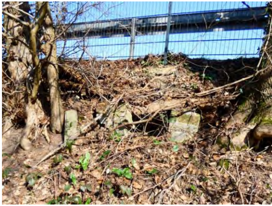
Abb. 4.7-13: Rohrdurchlass vom Dreiecksweiher zum Düffjes Puhl 10.03.2025
