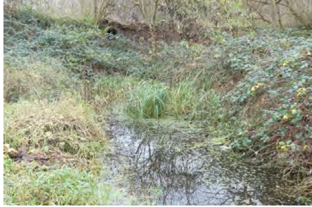
Abb. 4.7-14: Hochwasserentlastungsrohr östlich vom Auensee 31. Dezember 2024
