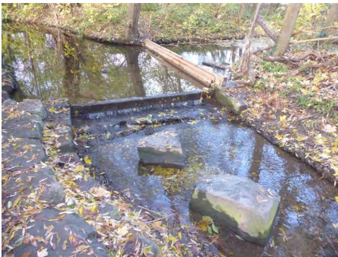
Abb. 4.4.2-5: Aufteilungsbauwerk „Große Laache“ 24. November 2019
