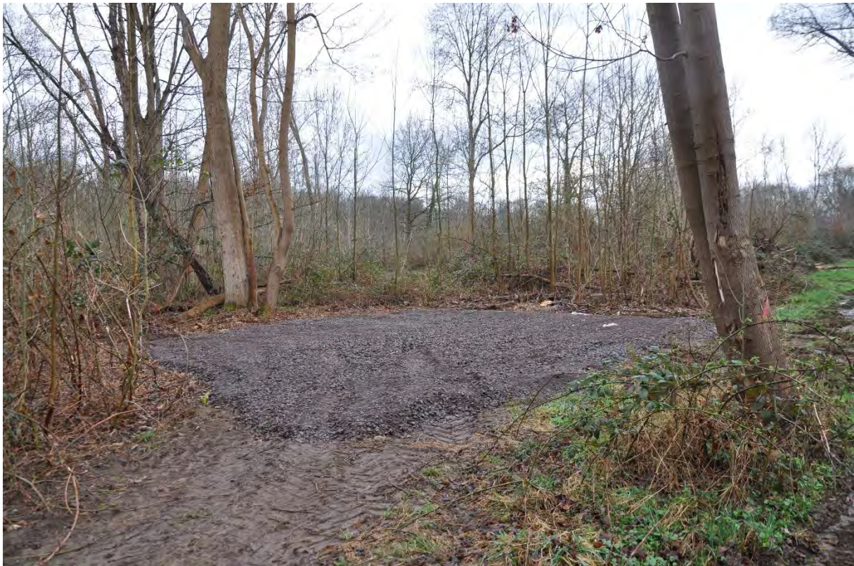
Abb. 6.5.2-2: Aufschüttung mit grobkörnigem Schotter im NSG östlich des Langen Weiher s
