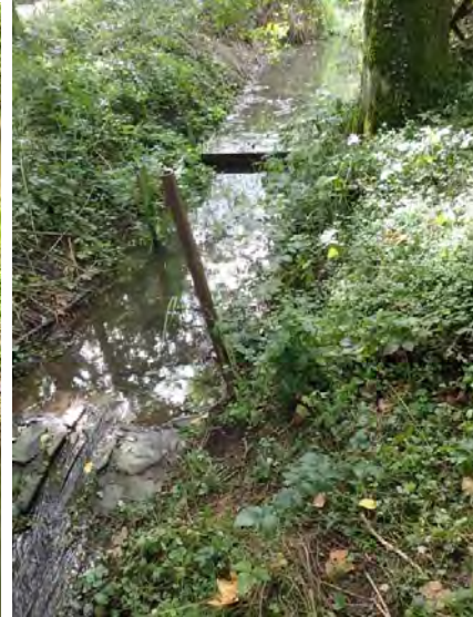
Abb. 4.4.2-9: Schlitzdrossel Quergraben 27. September 2024
