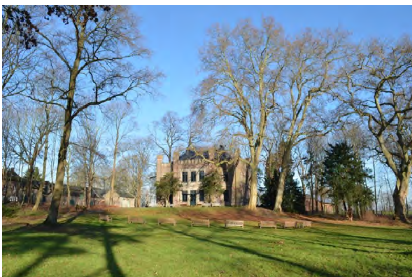
Abb. 4.2-8: Haus Orr auf Aufschüttungsrampe 05. Januar 2015
