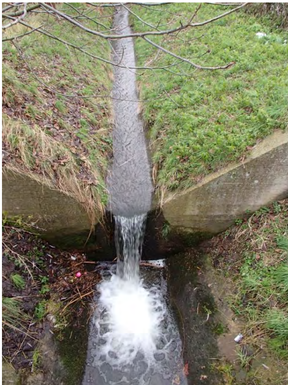
Abb. 3.1-20: Betonsturz vor Renaturierung 14.12.2012
